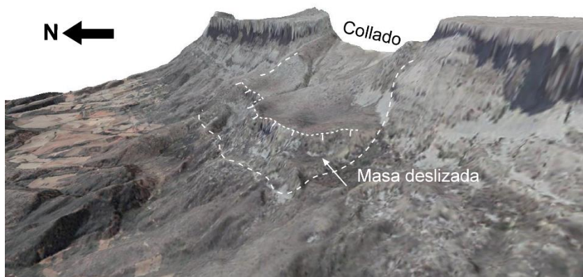
Figura 6: Deslizamiento de la Peña Villanueva. Nótese que los acantilados de la parte superior han bajado de cota en la masa deslizada.
